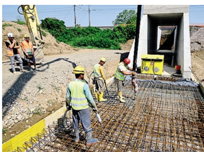
I lavori propedeutici all'inserimento dei manufatti FOTO BEDOLIS
