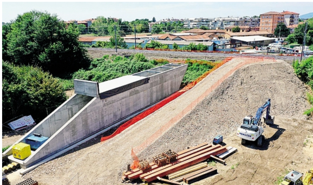
Uno dei monoliti che saranno «spinti» sotto il tracciato della ferrovia. Saranno passaggi ciclopedonali
